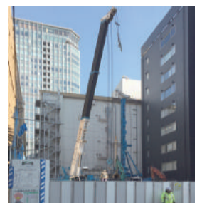
工事が進む旧麹町保健所跡地
